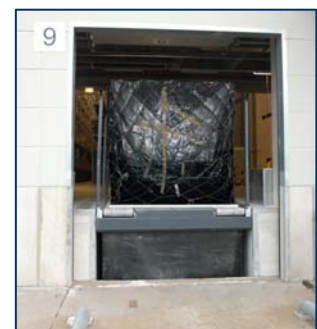
Wettergeschützte Entladung der Luftfrachtcontainer über Rollen – Hubsystem
